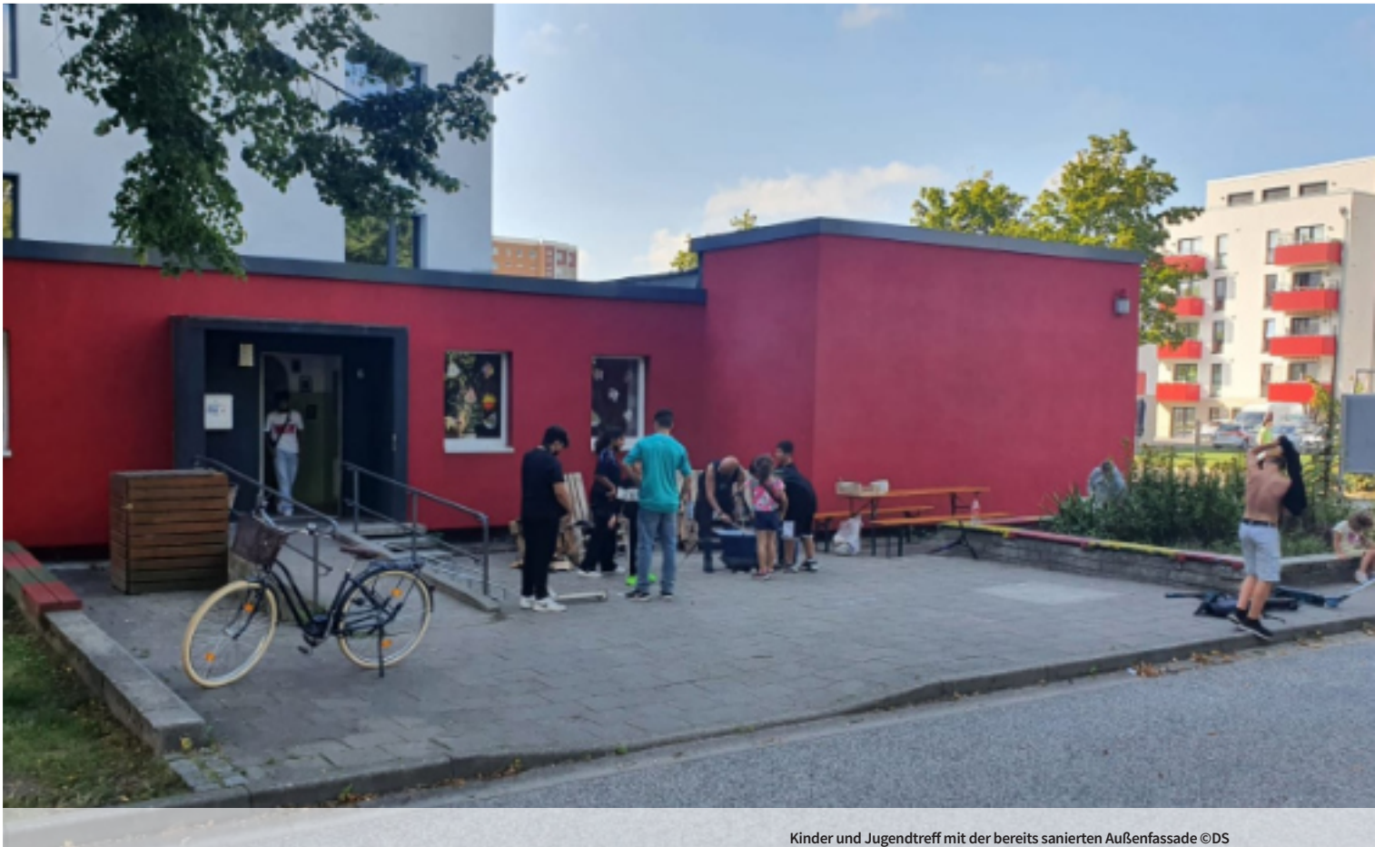
Kinder und Jugendtreff mit der bereits sanierten Außenfassade ©DS
